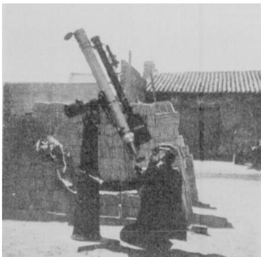
Figura D-59: El astrónomo Sr Castellanos operando con la ecuatorial Grubb y el aparato fotográfico Steinheil adaptado a ella.
