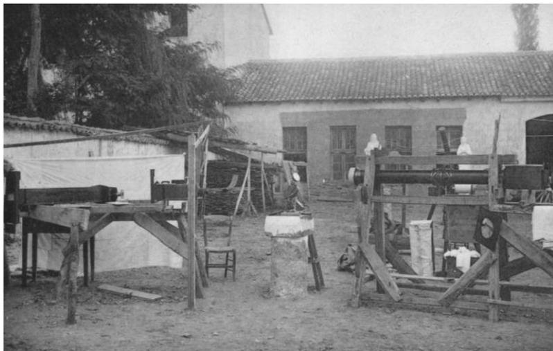
Figura E-26: Disposición azimutal de las cámaras prismáticas y el coronógrafo de 2.20 metros con el celostato. Página 37 del informe del director de La Cartuja.
